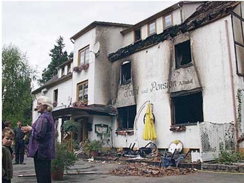
Gastwirtschaft, weitgehend auch Hotel und Pension des "Felsenkellers" sind zerstört. Die Polizei schätzt den Gesamtschaden auf rund 150000 Euro. Foto: jk
